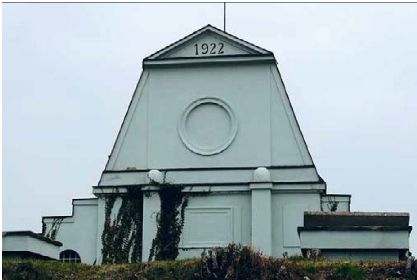
Obr. 14: Rynholec, úprava vody, jižní fasáda (foto A. Schubert, 2019).
