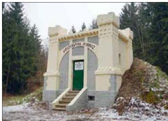
Obr. 4: Jesenice (okres Rakovník), vrchní vodojem na zalesněném svahu východně od města (foto M. Karellová, 2015).
