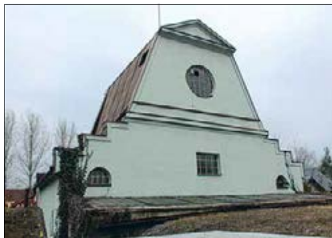
Obr. 13: Rynholec, úprava vody, severní fasáda (foto A. Schubert, 2019).
